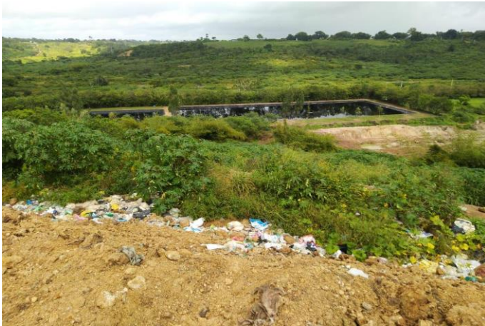
Figura 17. Vista das lagoas de chorume.
