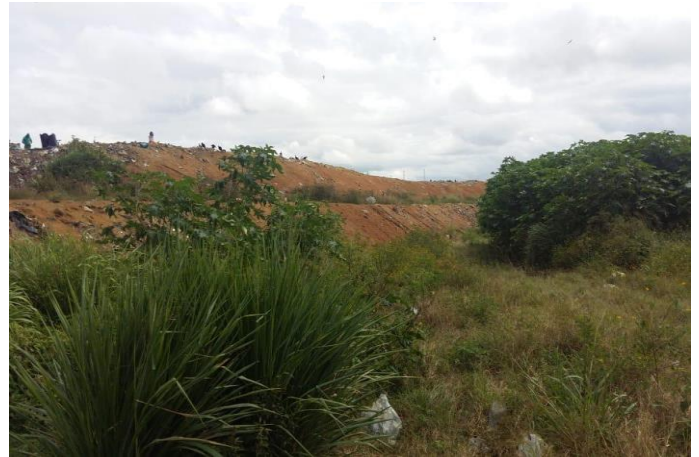
Figura 18. Vista dos taludes e berma do aterro.
