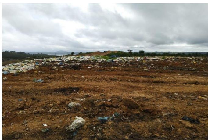
Figura 16. Vista de outro setor da frente de trabalho.
