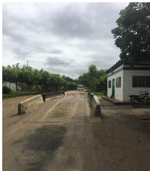
Figura 14. Detalhe da portaria e balança.
